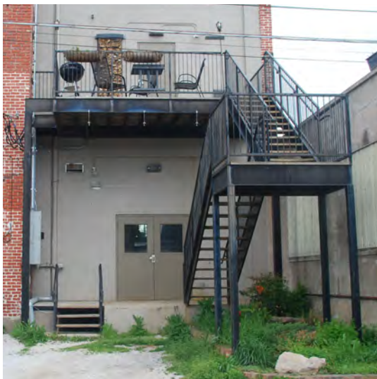
Image P19—Similar stair
